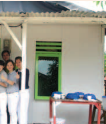
RUMAH YANG TEDUH. Bertahun-tahun rumah Yulma bocor sehingga tidak nyaman untuk ditinggali. Lubang-lubang di atap dan dinding rumah tersebut kini telah tertutup rapat dan memberi keteduhan kepada penghuninya.
